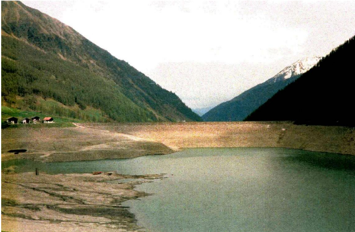
Figura 5: Foto della diga di Vernago (fonte: FCEM – 1/2).
