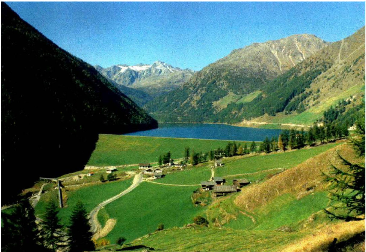
Figura 4: Foto della diga di Vernago (fonte: FCEM – 1/2).
