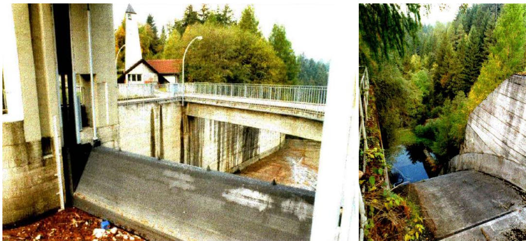
Figura 4: Foto dello scarico di superficie (fonte: FCEM)
